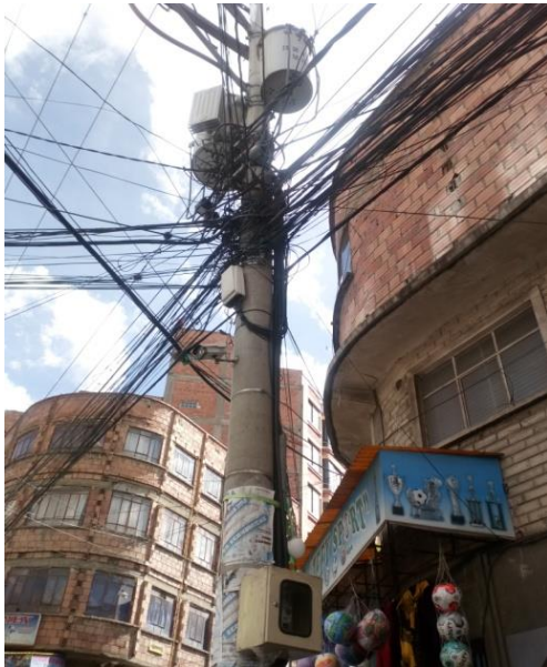
Figura 2. Centro de Transformación – Delta abierto. Crédito: Reynaldo Condori Paucara
