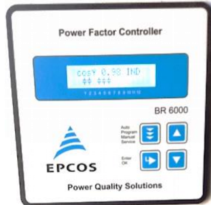
Figura 7. Valor actual del factor de potencia EPCOS BR6000. Crédito: C.Mendoza C.
